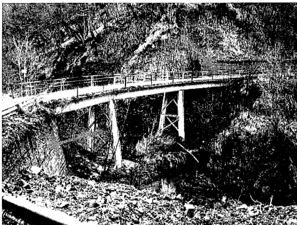
Fig. 1: L'attuale ponte con le strutture murarie di contenimento (freccie), che saranno mantenute
