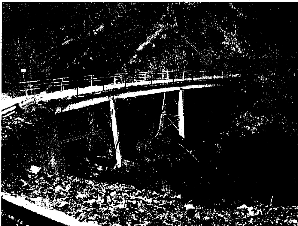
Fig. 1: L'attuale ponte con le strutture murarie di contenimento (freccie), che saranno mantenute
