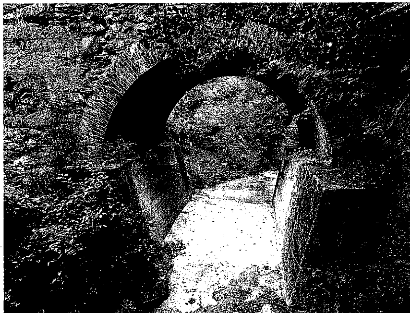
Fig. 4: Ponte sul Rio Cascinotto, pregresa artificializzazione dell'alveo con spalle in cemento armato
